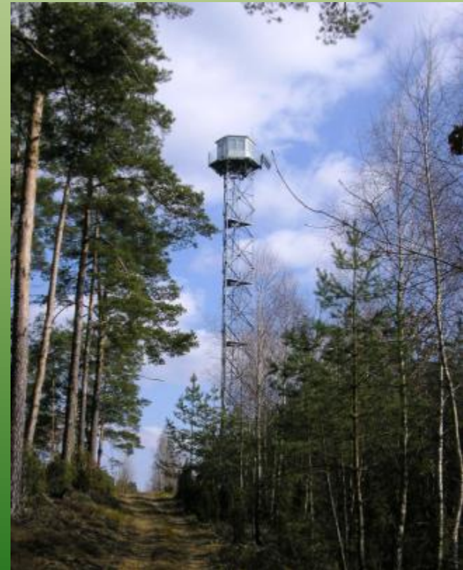
Dostrzegalnia ppoż. Dęby (konstrukcja stalowa)
