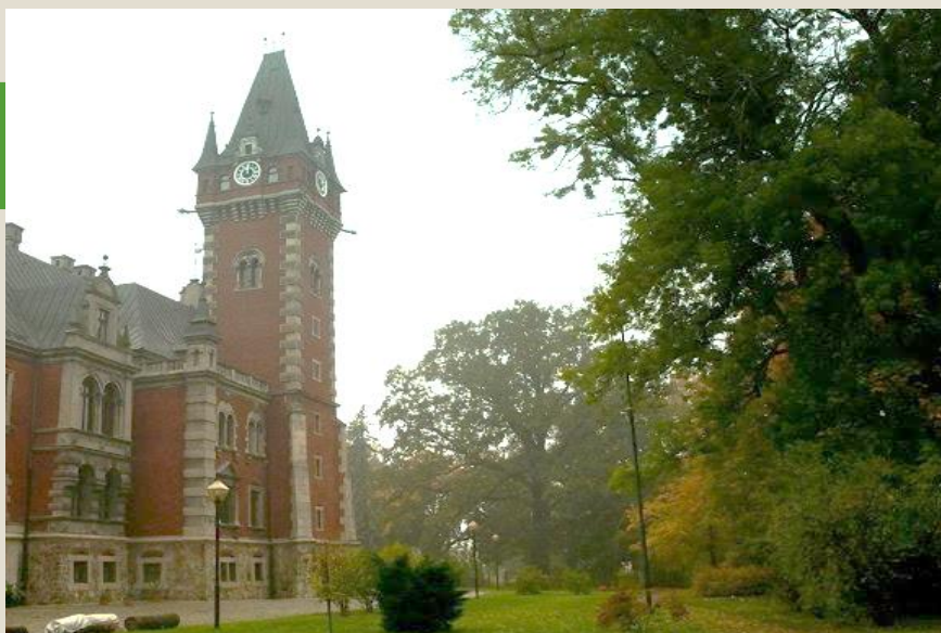
Pałac Ballestremów w Pławniowicach
